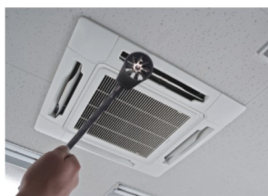
空调出风口测试
